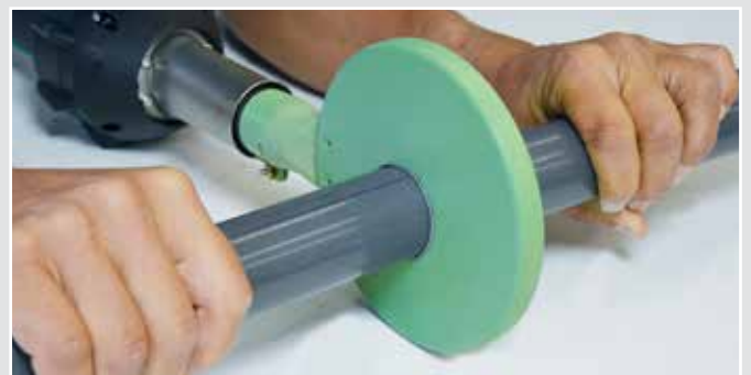
热板对接焊接
