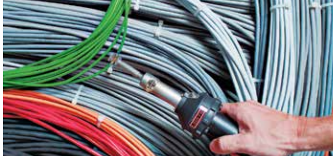
使用 HOT JET S 配合反射风嘴进行热收缩连接。
