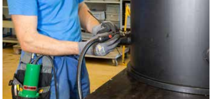
LABOR S 连接鼓风机 MINOR 进行焊接工作。
